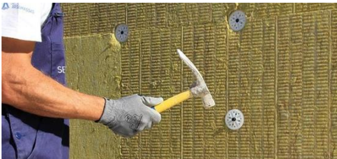
Figura 24 Exemplu dibluire vata minerala dupa lipire
