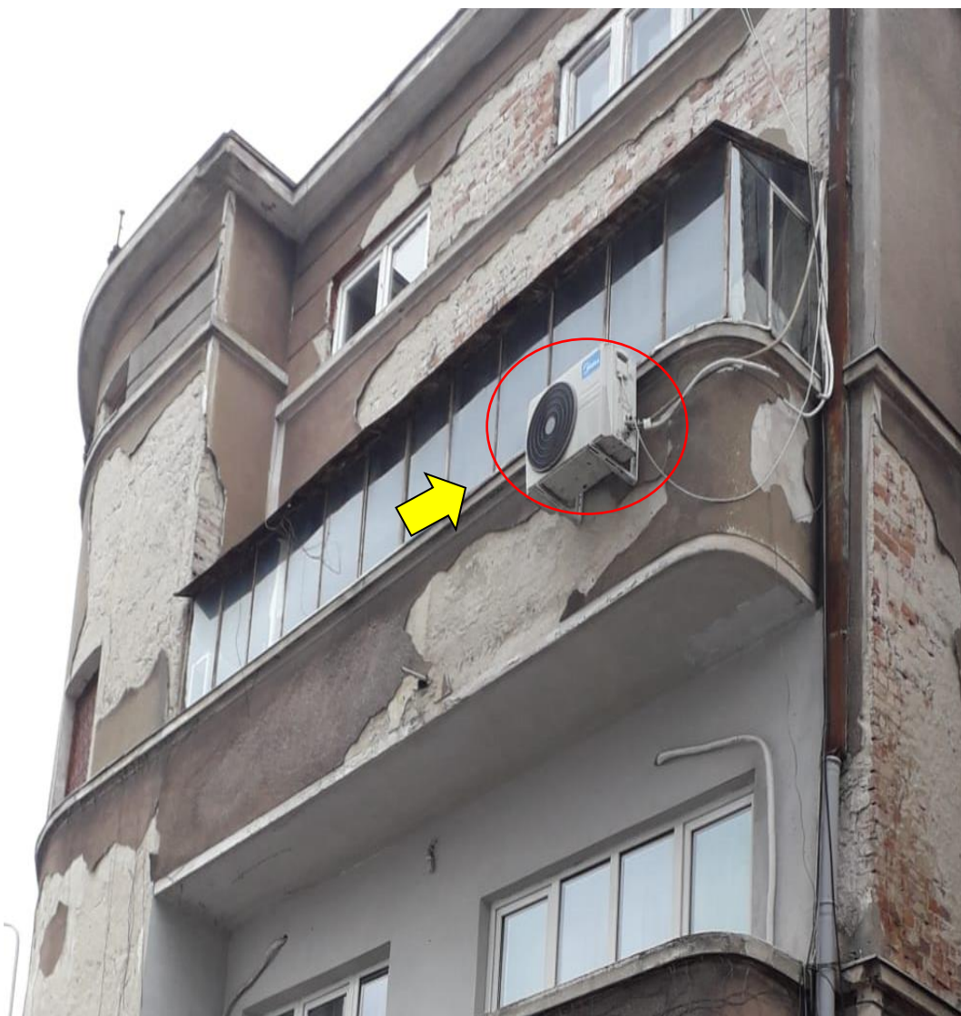
Figura 13 Aparat SPLIT pe fațada principală a clădirii
