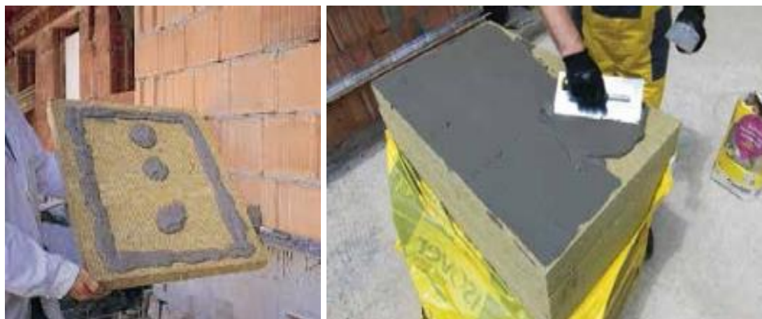
Figura 25 Exemplu de aplicare a adezivului pe vata bazaltică: „în puncte” sau „pe suprafața”
