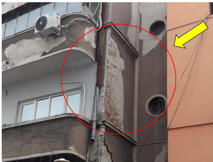
Figura 5 Uzura și decolorarea finisajelor exterioare
