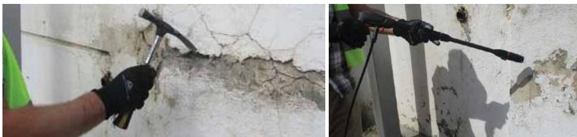
Figura 23 Exemplu curatare pereti exteriori cu tesla si cu un aparat de spalare cu presiune
